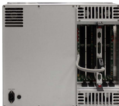
Vista interna posteriore
